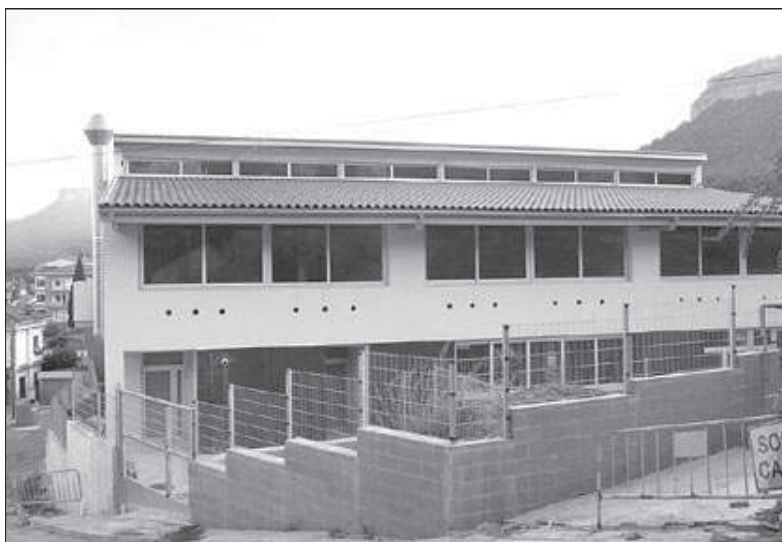
Les obres de construcció del nou edifici de l'escola es troben en un estat avançat
