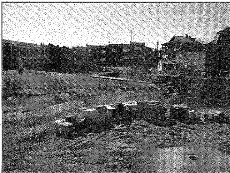
El dipòsit de la Salle s'enderrocarà cap al juny (AdBM)
