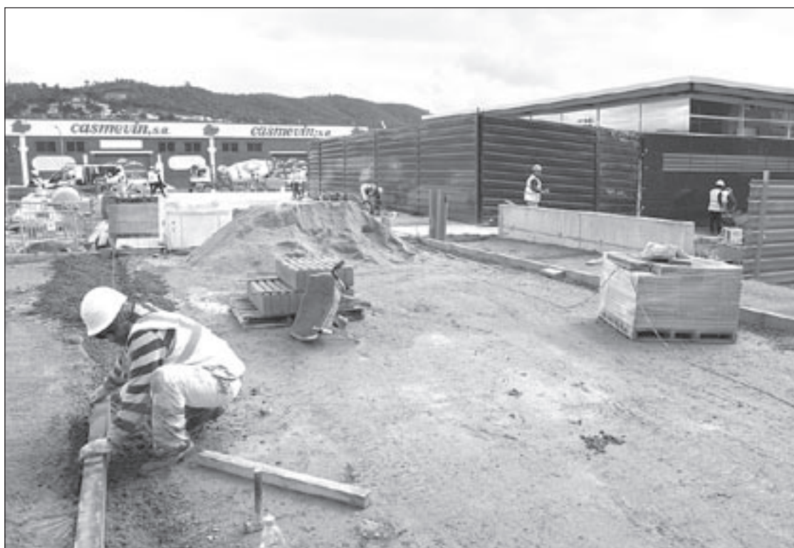
Els operaris treballen a contra rellotge per enllestir la urbanització dels vials d'accés a la nova estació de Montmeló
