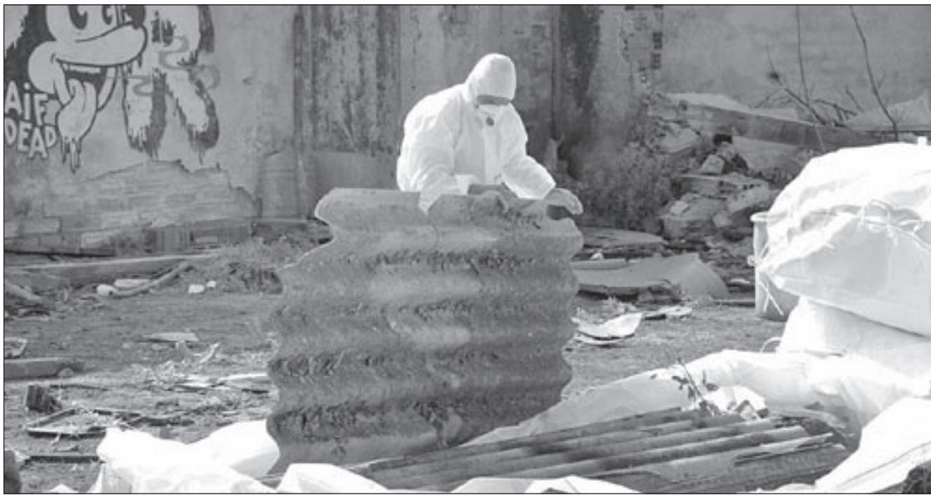
El tractament de la uralita que es retira es fa amb totes les mesures de seguretat per la toxicitat de l'amiant
