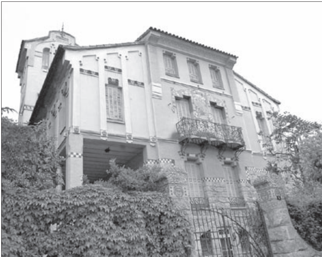
La façana principal de Can Barbey, a l'illa Raspall de la Garriga
