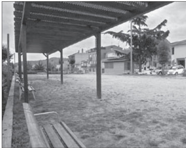
La pèrgola instal·lada ultima les actuacions a la plaça
