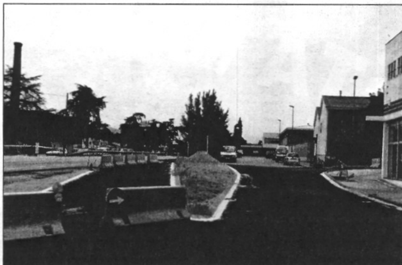
Les obres de la calçada lateral de la C-35 han alterat la mobilitat de la zona (L'AIMB)
